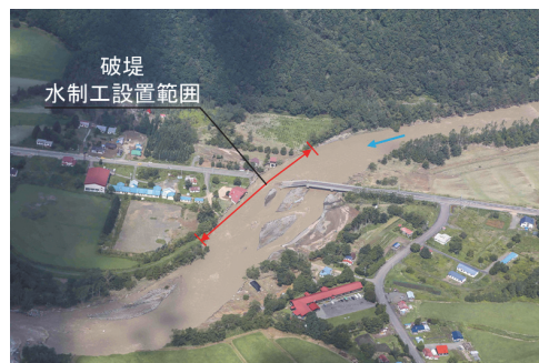
写真-1 被災状況（沙流川）
