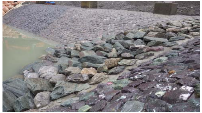
写真 6 石組み魚道の完成状況
