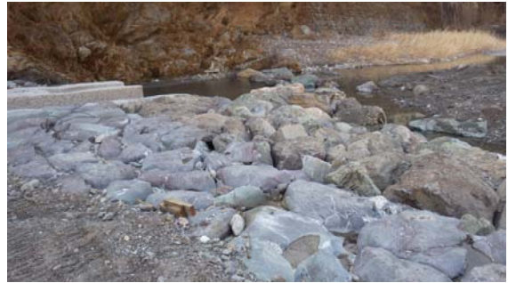
写真 7 魚道下流端の隔壁損傷に伴う巨礫設置
