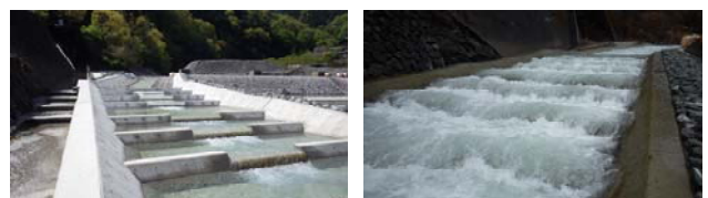
a) 渇水時の流況 b) 豊水時の流況 写真 4 台形断面魚道の流況
