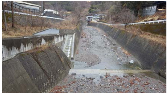
写真 8 10m 落差の折り返し台形断面魚道
