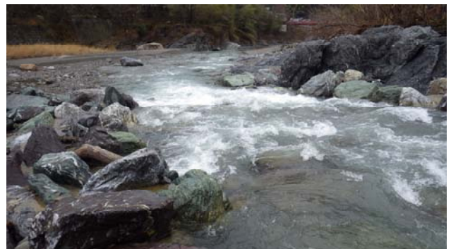
写真 5 新設魚道下流側の石組み河道内の流況
