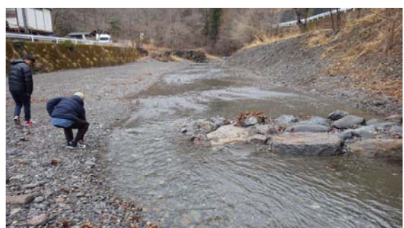
写真 9 滞筋の安定化のために工夫した状況
