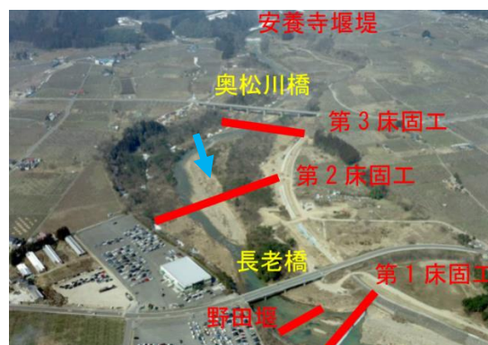
図1 松川遊砂地の状況
