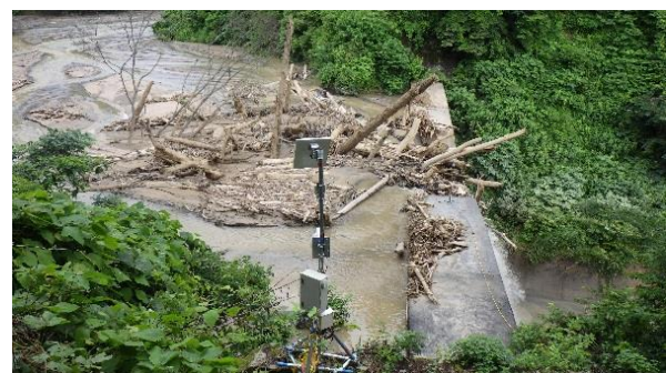
写真-1 桑名川砂防堰堤により捕捉された土石流と流木（平成 29 年 7 月撮影）
