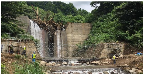
写真-2 桑名川砂防堰堤の副堰堤に設置した 強靱ワイヤーネット工（平成 29 年 8 月撮影）
