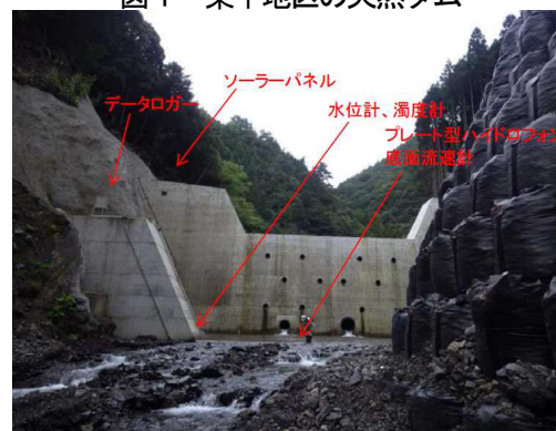
図2 栗平地区観測機器設置状況 (下流側より撮影)
