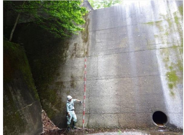
写真-1 胡桃平1号砂防堰堤の拘束ひび割れ
