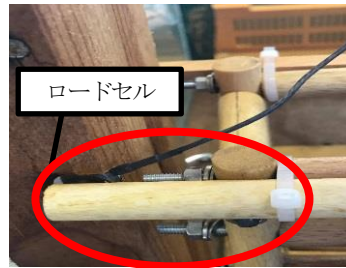
写真6 ロードセルの設置
