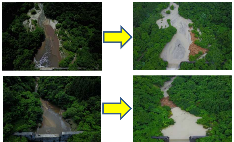
図3 平成29年8月1日の出水により発生した流木捕捉状況
