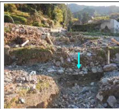
写真 7 土砂堆積状況
