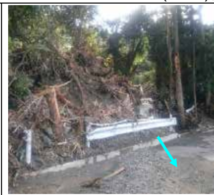
写真 6 町道橋(上流側閉塞)
