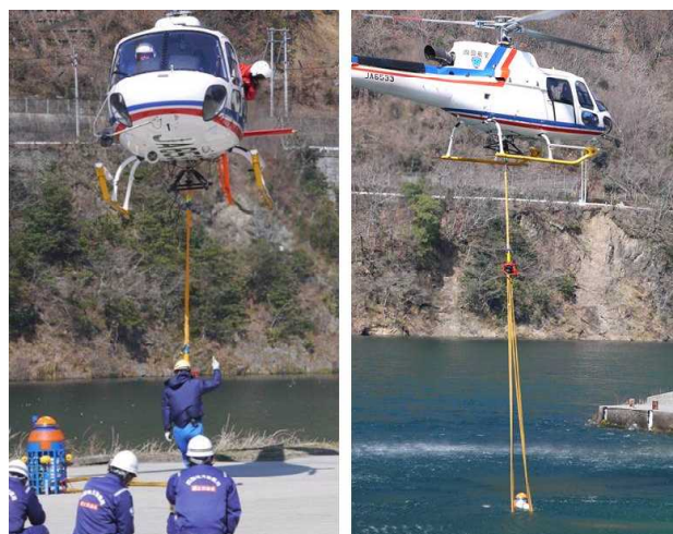
図３ 水位計の吊り上げ・設置
