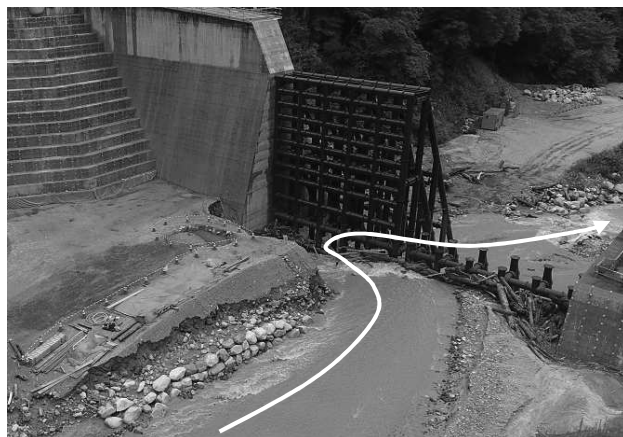
写真3 越百川第3堰堤_流木捕捉時（上流側上空より）
