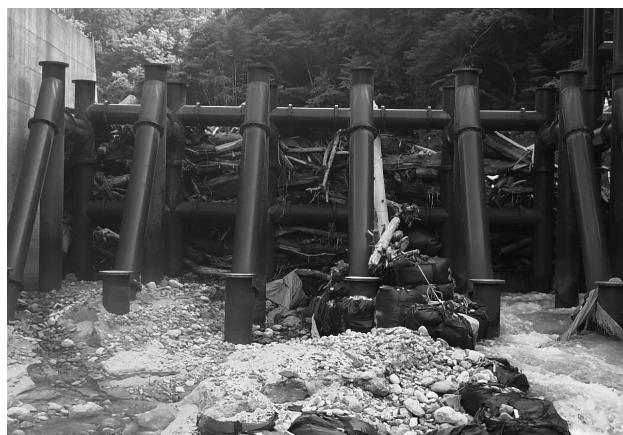
写真4 越百川第3堰堤_流木捕捉時（下流側より）
