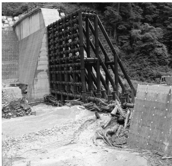
写真1 越百川第3砂防堰堤の段階施工中（第2期施工）における流木捕捉状況（上流右岸側より）
