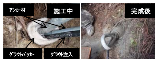
写真-2 河床部のグラウト亀走防止対策(例)
