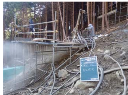
写真-1 削孔状況(転石が多い地盤)
