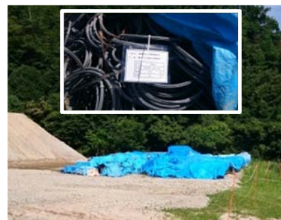
写真-3 撤去後の保管状況(例)
