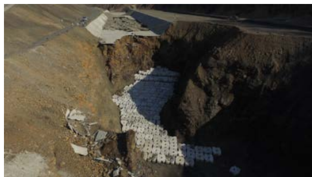
図5 無人化・分解型BHにより設置した根固めブロック
