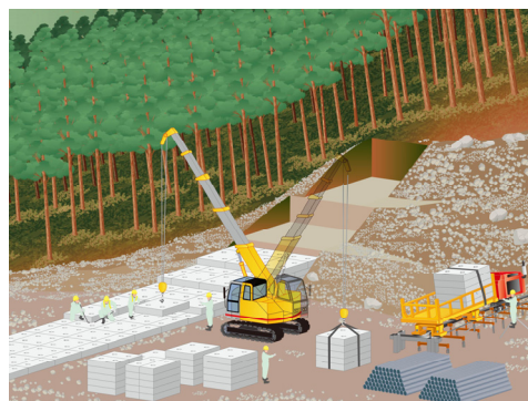
図-3 鋼管補強コンクリートブロック堰堤
