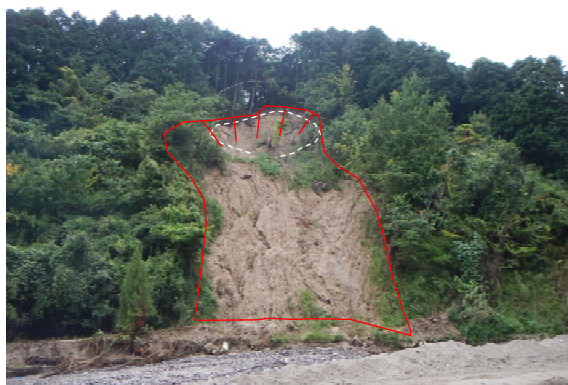
図 4 表層崩壊箇所(a)
