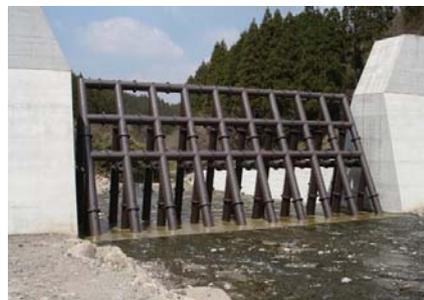
写真-1 鋼製透過型砂防堰堤
