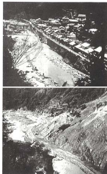
写真 1 二川崩壊前(上)、崩壊後(下)
