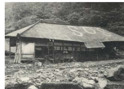
写真3 災害時の安諦小学校沼谷分校
