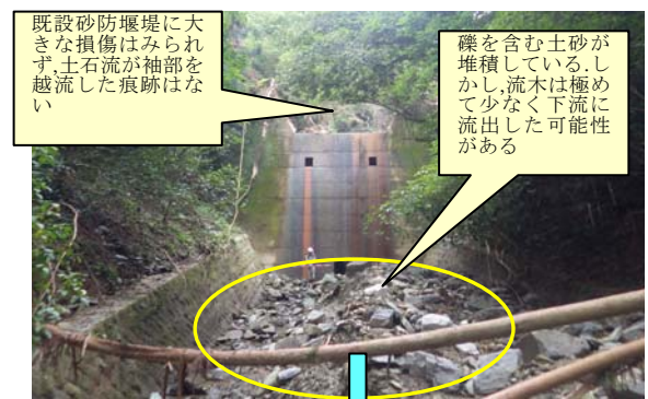
写真-3 既設不透過型砂防堰堤の状況
