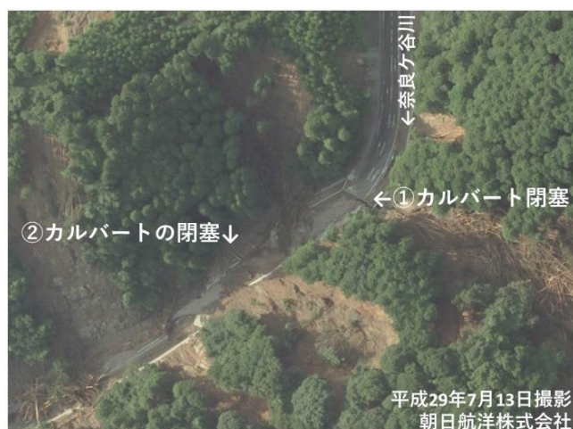
写真-1 カルバートの閉塞箇所(奈良ケ谷川)
