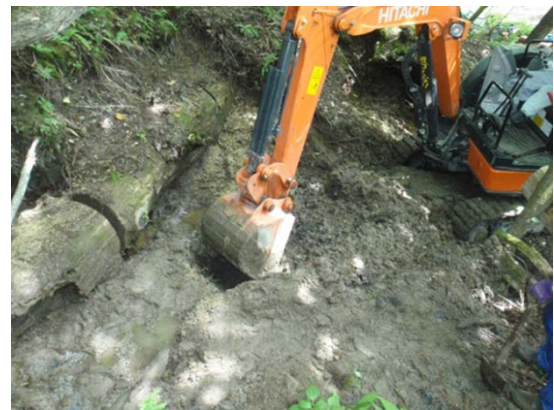
写真1 重機による掘削作業と倒木の裁断
