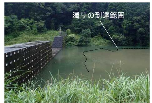
写真-1 堰堤での濁り滞留状況
