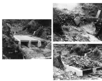
図－1 底面水抜スリット
