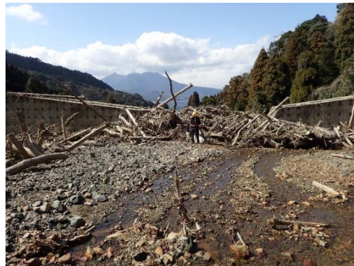
図-2 平野川第2号砂防堰堤の堆砂地の状況
