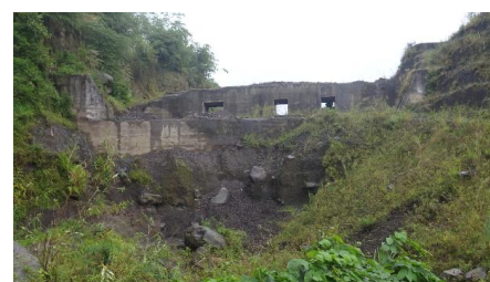
図 5 副堰堤下部までの掘削事例
