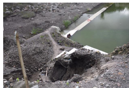
図 6 護岸工背面側までの掘削事例
