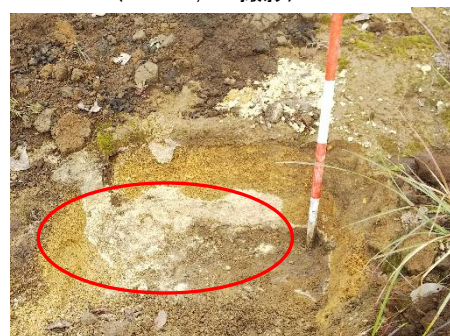
図 2 白色物質の液状化疑い箇所 (2017 11/18 撮影)
