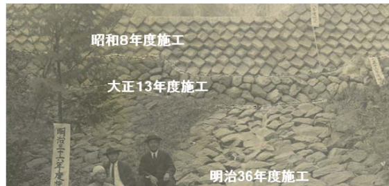
図-10 逆瀬川の砂防堰堤（兵庫県砂防課提供）
