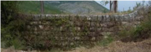
図-6 マーニタス溪（クロアチア）の砂防堰堤（1900 年頃施工、2016 年著者撮影）
