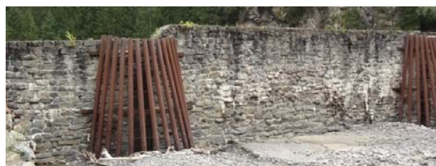
図-3 フィッシー溪（オーストリア）の砂防堰堤（1900 年頃施工、2013 年著者撮影）
