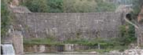
図-5 サンジオルジオ砂防堰堤（イタリア）（1880 年施工、2014 年著者撮影）
