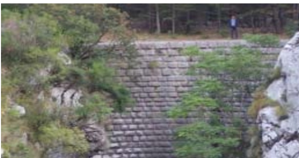
図-7 シュクルダ溪（モンテネグロ）の砂防堰堤（1897 年施工、2016 年著者撮影）
