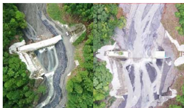
図 7 豪雨後の栗平 1 号砂防堰堤の堆砂状況（左：台風 5 号後，右：台風 21 号後）
