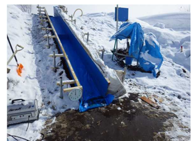
写真-1 実験水路斜面 全景
