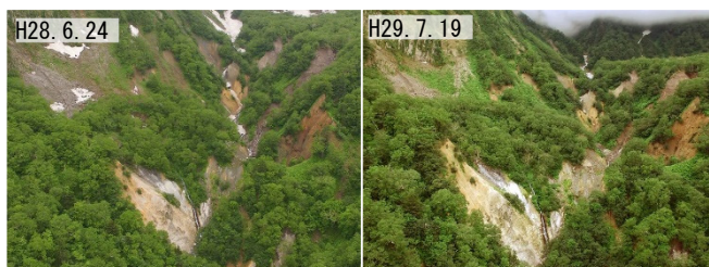
写真② 斜面に大きな変化がみられない。
