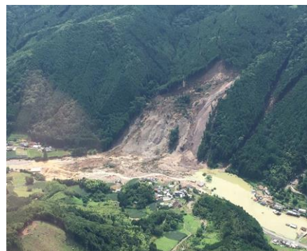
写真 2 九州北部豪雨で発生した規模の大きな崩壊 大分県日田市小野地区。(2017 年 7 月 9 日海堀撮影)
