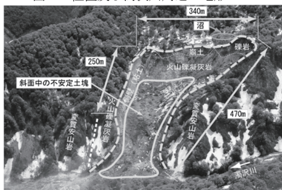
写真. 1 池ノ台地区の崩壊発生状況
