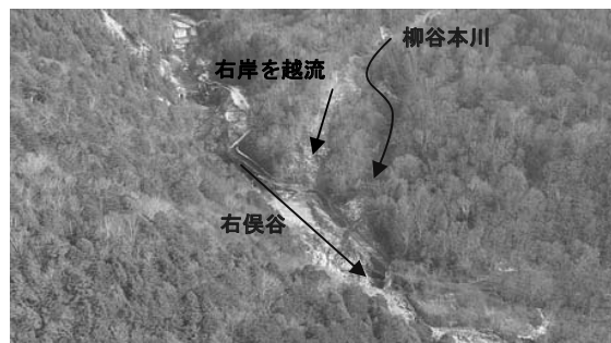
写真-1 右岸の越流痕跡
