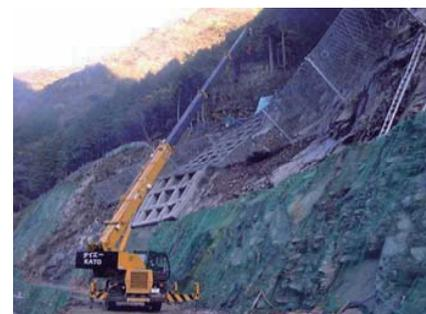
写真-5 高エネルギー柵の除石作業
