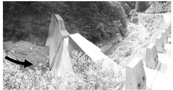
写真 2 野中沢砂防えん堤(コンクリートスリットえん堤)
