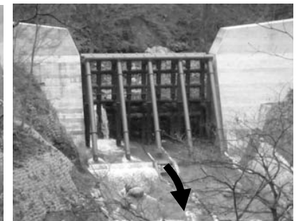
写真 5 竣工時 (野中沢第 2 号砂防えん堤)
