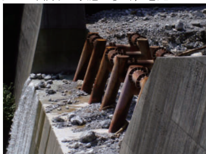
写真-1 部分透過型が機能した事例
