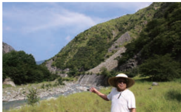
写真-1 足尾松木沢の状況 (2011/08/15)
