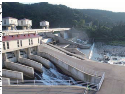
写真1 現在の横江堰堤(H22撮影)
