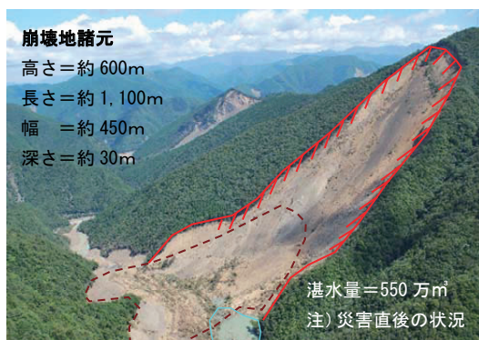
写真-1 河道閉塞箇所(赤谷地区)
