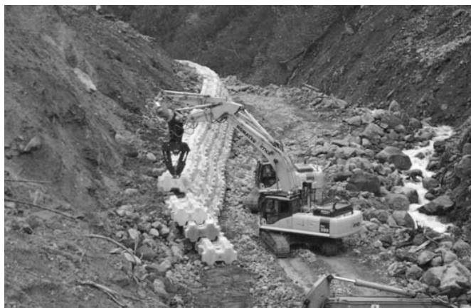
写真1 無人化施工実施状況
