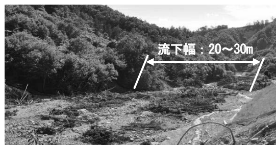
写真-2 災害当時の河川状況
