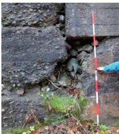
図1 堰堤破損状況 (C砂防堰堤)
