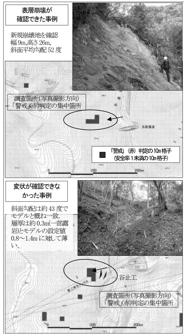
図-4 台風12号・15号後の現地調査状況
