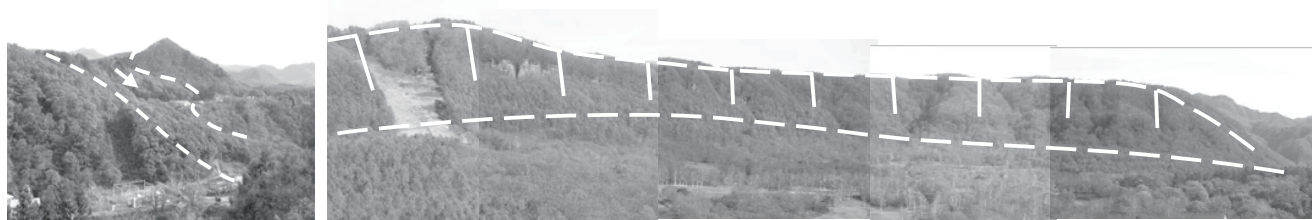
図 3 基盤を巻いて流下する藤原崩れの流動化部分を下流側から望む(左)；連続する滑落崖と崩土が形成する平坦面(右)
