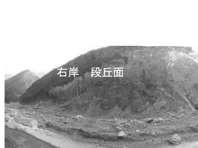
写真-3 河原樋新湖天然ダムの堆積断面と航空写真
