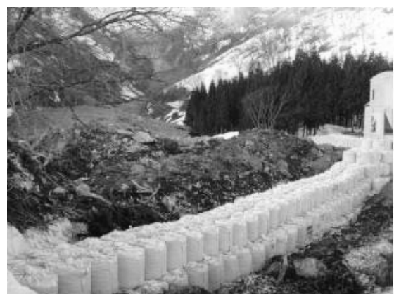
写真-2 大型土嚢による応急対策（長野県北信地方事務所）
