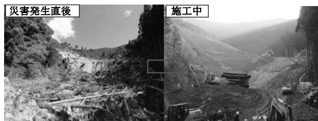
写真-3 仮排水路(天然ダムを下流から望む)
