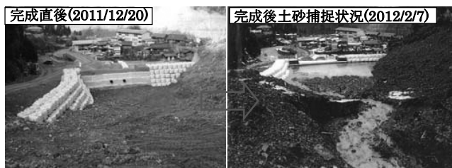
写真-4 仮設堤(上流から望む)
