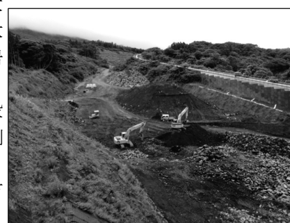
図 2 大宮沢溶岩導流堤施工状況
