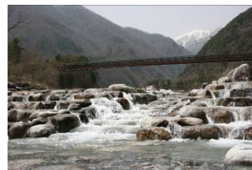
図2 太田切床固工群と中央アルプス
