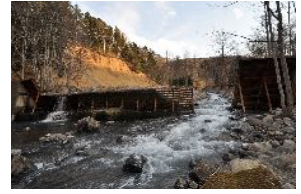
写真3 No.12鋼製えん堤
