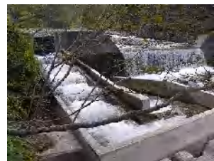
写真5 No.1コンクリートえん堤
