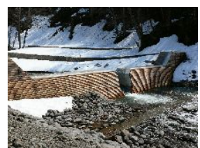
写真 2 No. 8コンクリートえん堤
