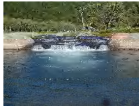
写真4 No.3コンクリートえん堤
