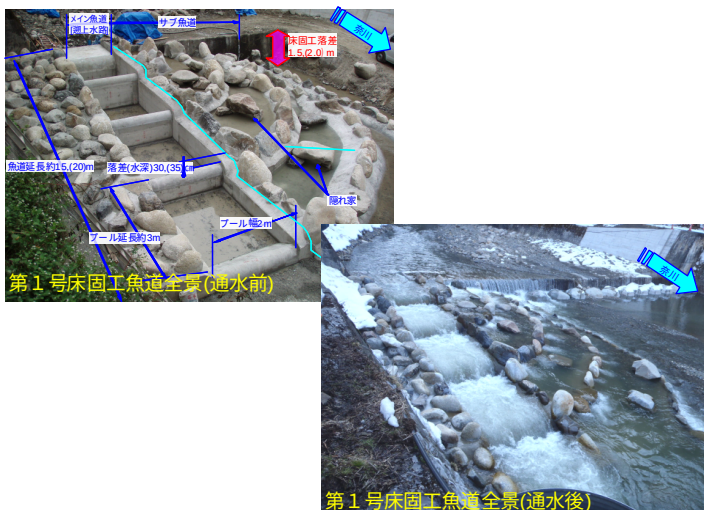
図 3.1 第 1 号床固工魚道(通水前:上、通水後:下)
